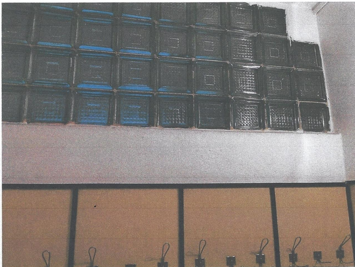
Fot.3 Rozbórka ściany działowej
