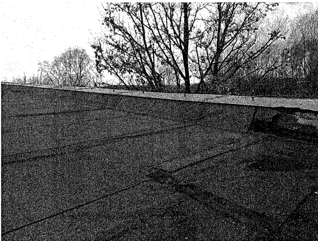
4. Widok ogólny pokrycia i murków attykowych
