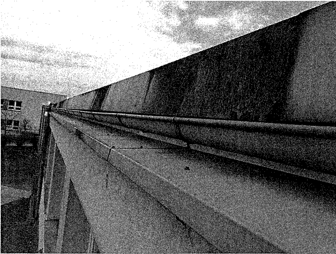
7. Widok obróbek pasa okapowego i orynnowania
