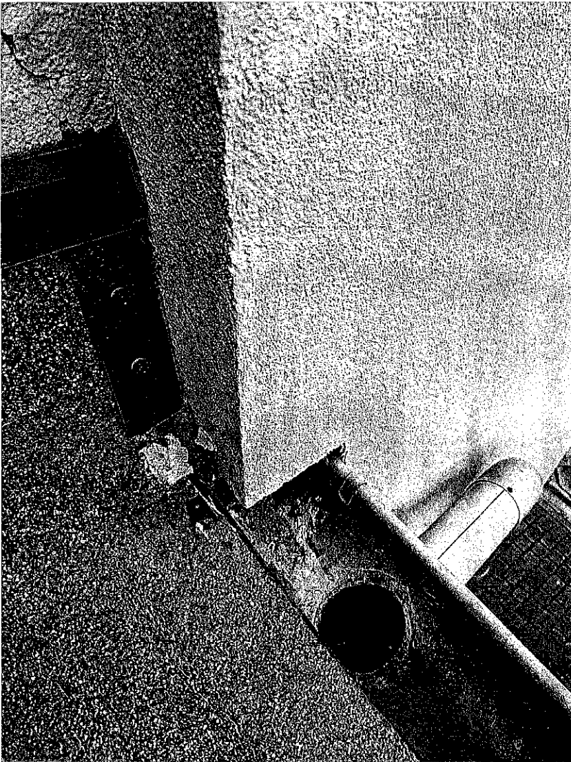
11. Widok zakończenia obróbki przy ścianie i wlot do rury spustowej od strony północnej
