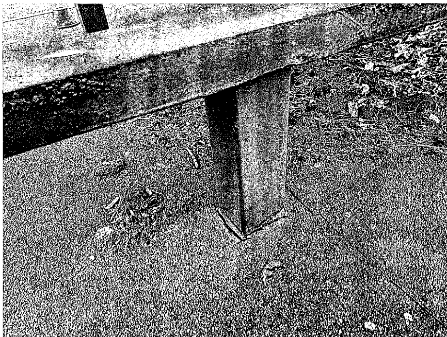
9. Widok przejścia konstrukcji solarów przez pokrycie dachu
