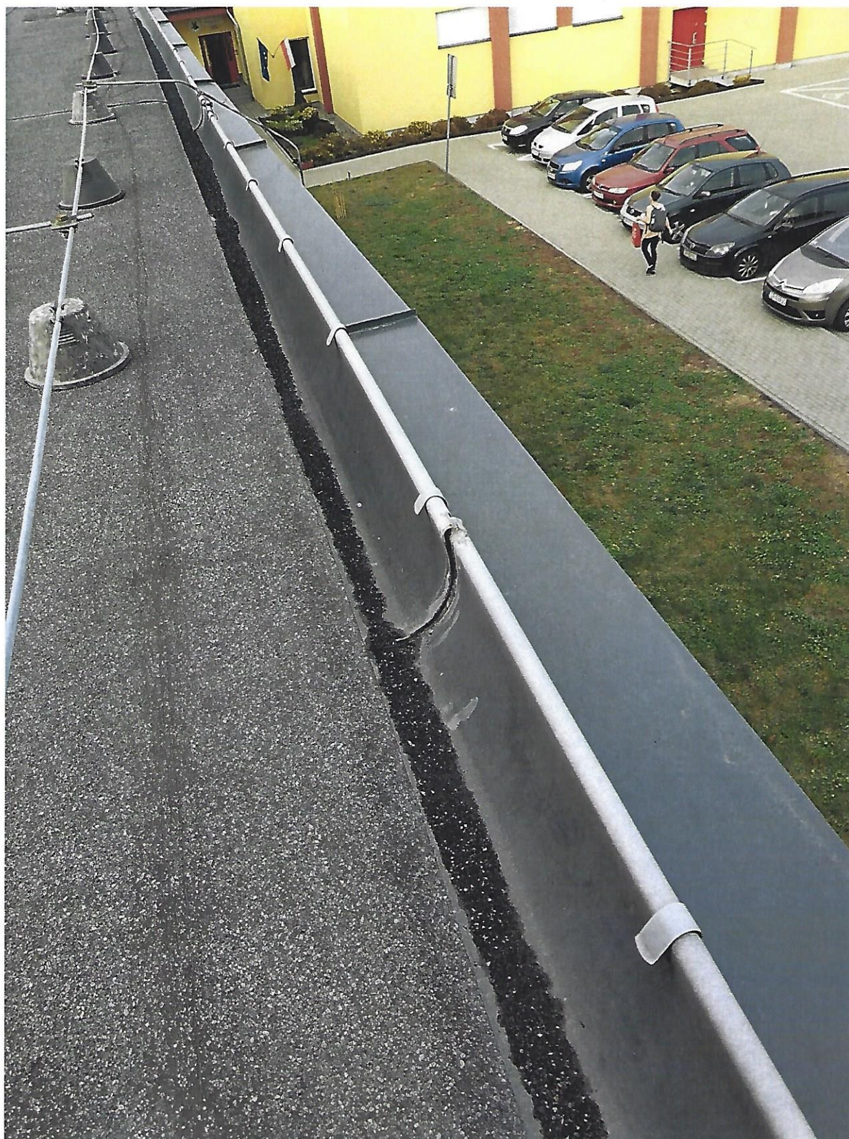
Fot. 6 Nieszczelne połączenia rynien.
