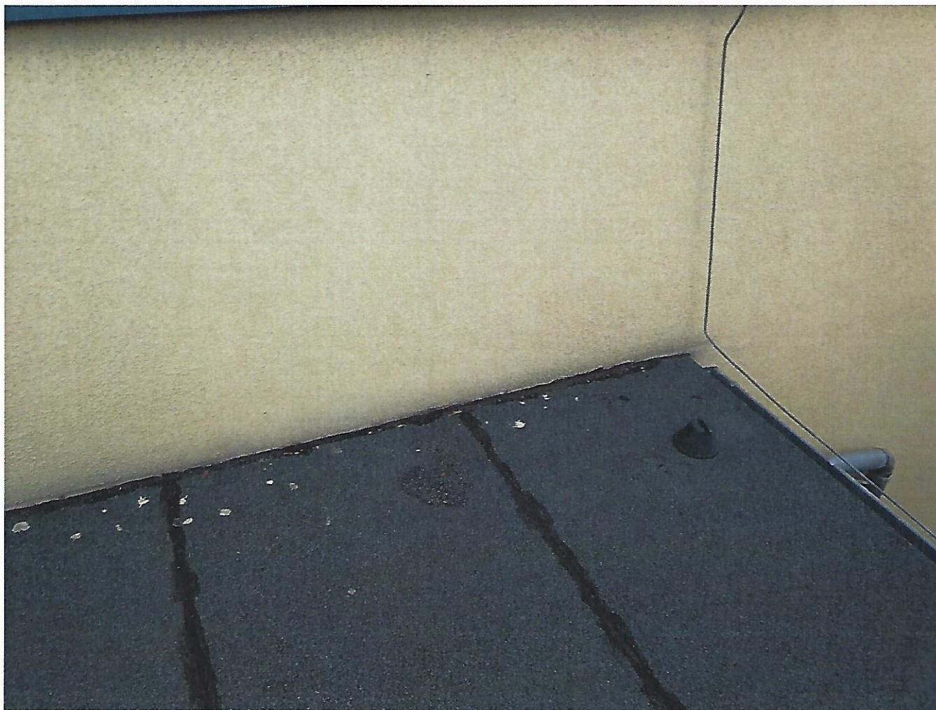
Fot. 8. Naprawa obróbek oraz miejsc styku ze ścianą elewacyjną.
